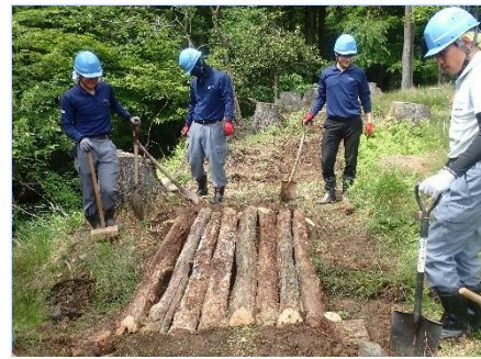
５月２２日 大和ハウス様 整備作業
