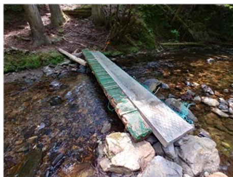
北谷橋(再敷設後)
