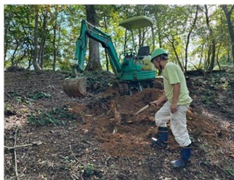
太陽生命の森林 遊歩道整備
